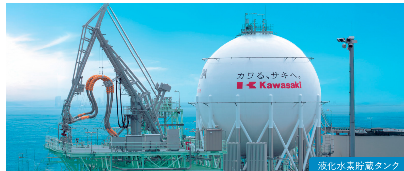
液化水素貯蔵タンク
